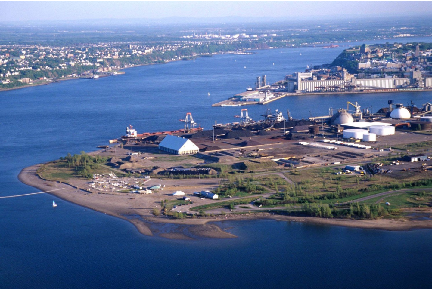
Photo : ministère des transports du Québec (avant 2008).
